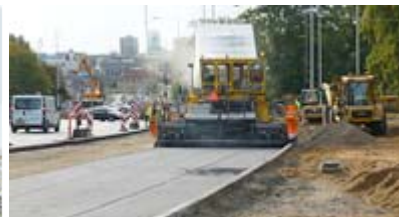
Foto fra anlæggelsen af første etape
