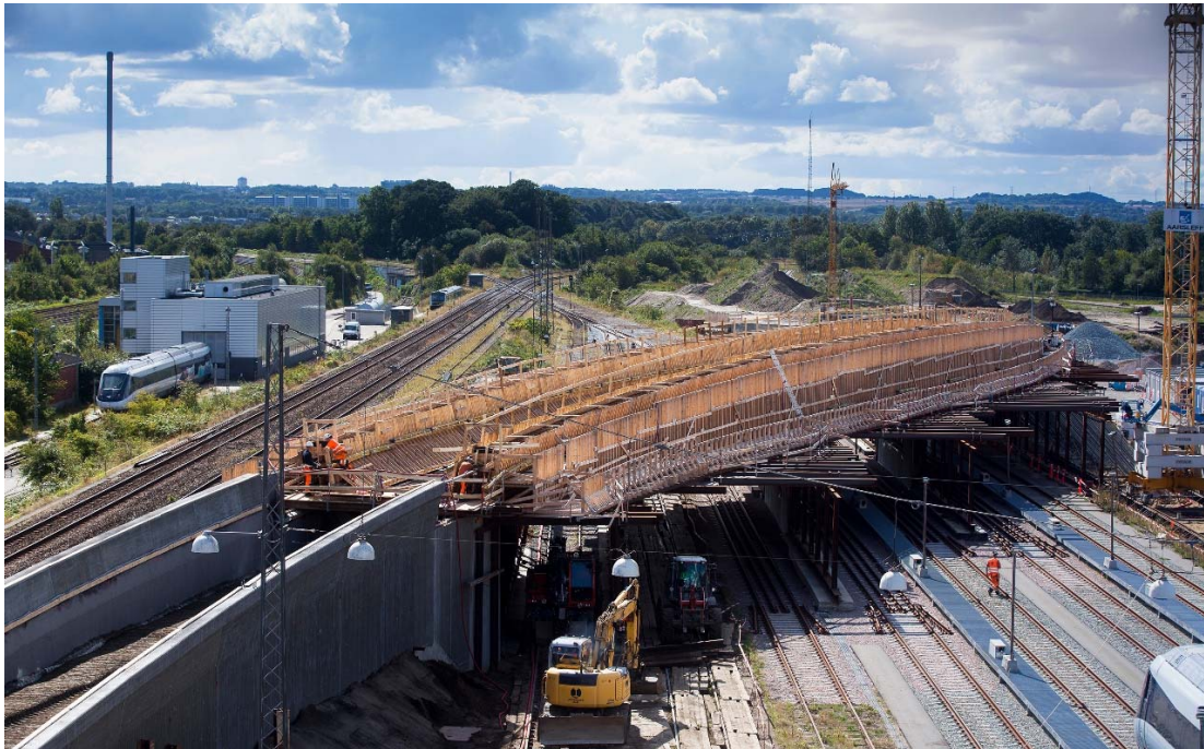
I august 2014 blev der støbt betondæk på letbanebroen over Banegraven, der krydser syv spor i sporgruppe 400.
