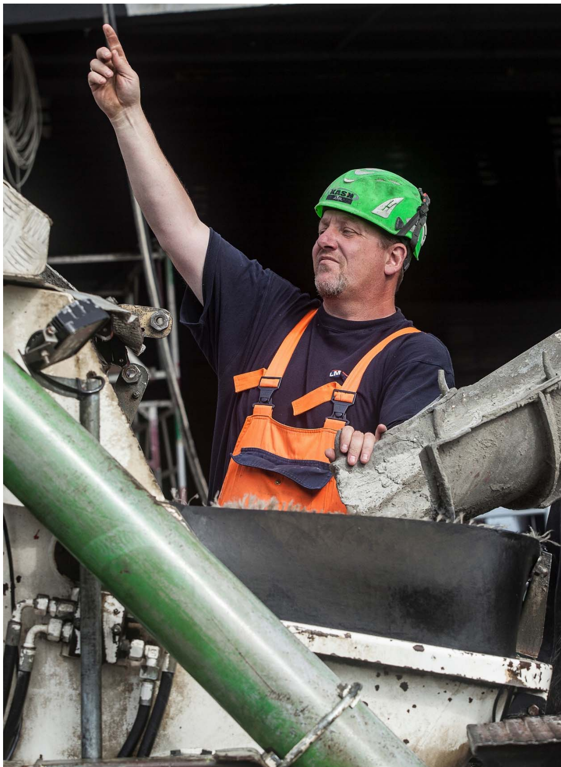
Støbningen af betondæk på letbanebroen over Mindet september 2014 blev færdig til tiden, så Grenaaanen som aftalt kunne genåbne 17. oktober.
