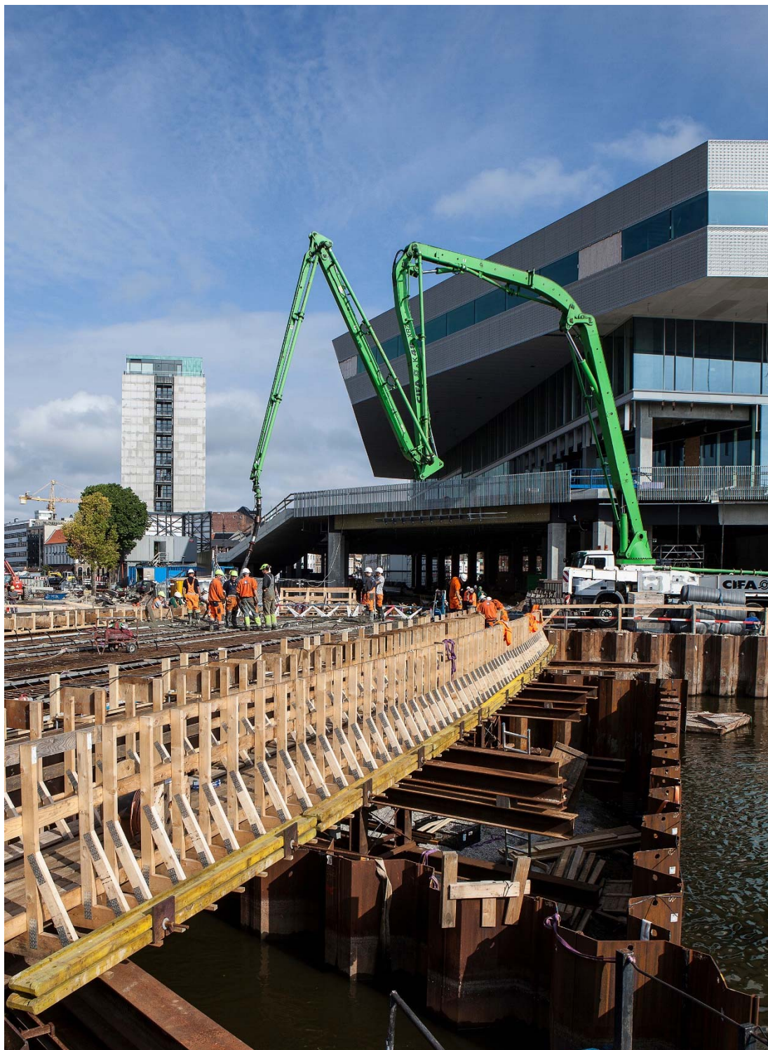
Broen over Mindet, september 2014. Støbningen af brodækket til den 30 meter lange og 11 meter brede bro krævede 36 tons jernarmering, 620 tons beton og mere end én kilometer trækør til kabler.
