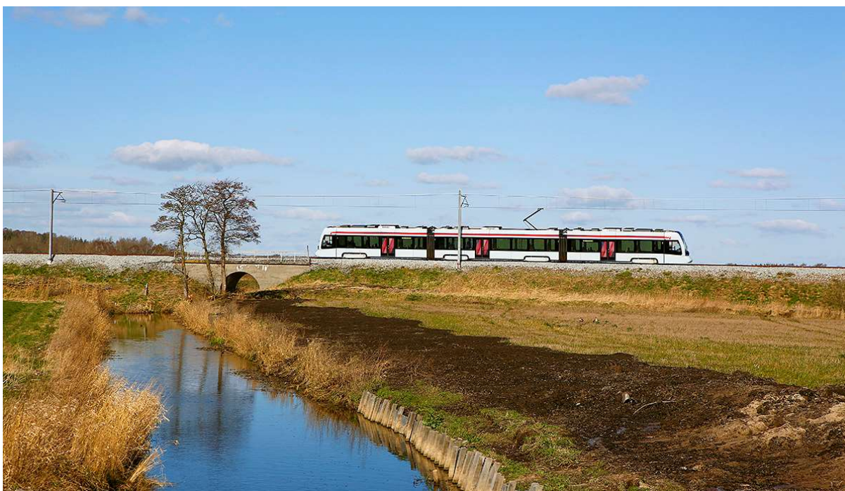
20. marts 2019 begyndte de afsluttende testkørsler af strækningen mellem Aarhus og Grenaa – her midt på Djursland. Chili Foto.
