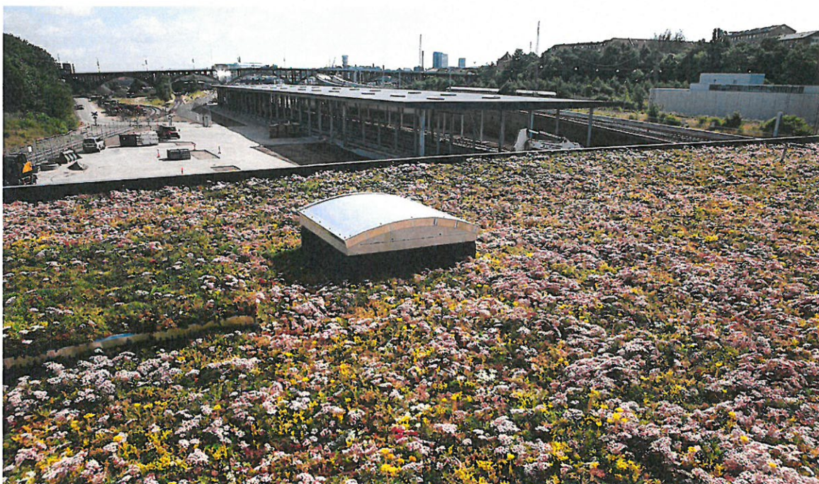
Letbanens nye værksted og kontrolcenter har grønne planter på taget. Planterne opsuger 12 ton CO 2 om året og er straks blevet hjemsted for bier og andre insekter, der ellers har svært ved at klare sig i Banegraven. Chili Foto.
