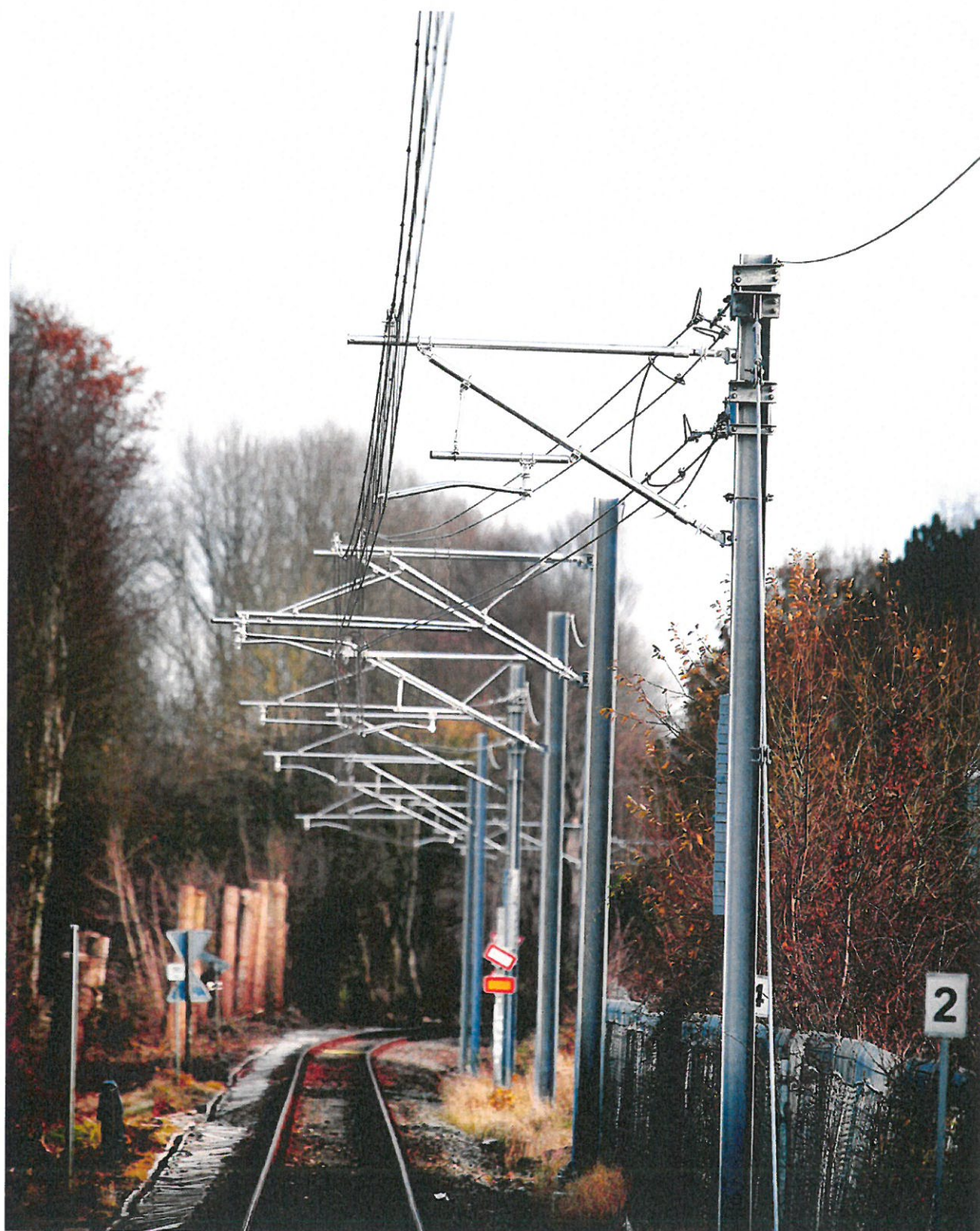
Midt på året begyndte arbejdet med at etablere kørestrøm for alvor. Her fra en 1.500 meter lang strækning omkring Øllegårdsvej i Viby, der benyttes til test af letbanetogene. Chili Foto.
