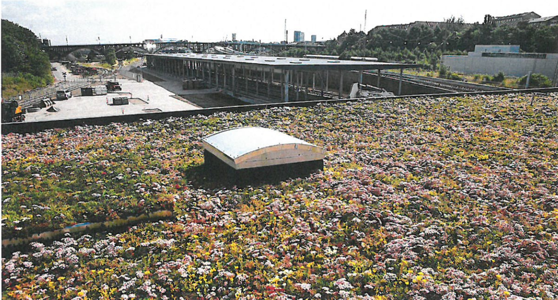
Planter på Trafik- og Service Centerets tag opsuger 12 ton CO2 om året og forsinker nedsvivning af regnvand. Chili Foto.
