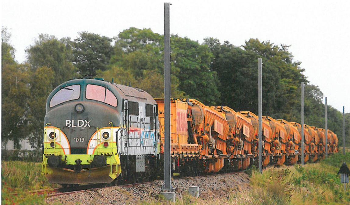
I september 2017 afsluttede Banedanmark deres del af arbejdet med at hastighedsopgradere Grenaabanen. Chili Foto
