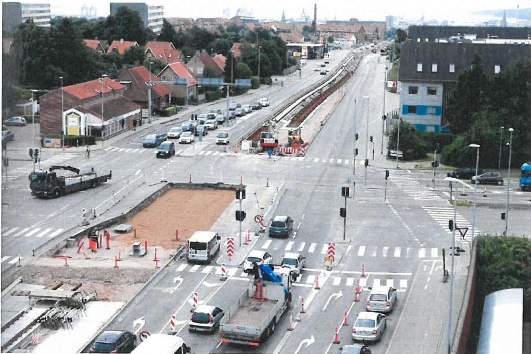
Med ca. 30.000 biler i døgnet er krydset mellem Randersvej og Ringvejen blandt Aarhus' mest trafikerede. Arbejdet med at lægge skinner i krydset forløb uden uforudsete problemer. Jens Hasse/Chilli Foto.
