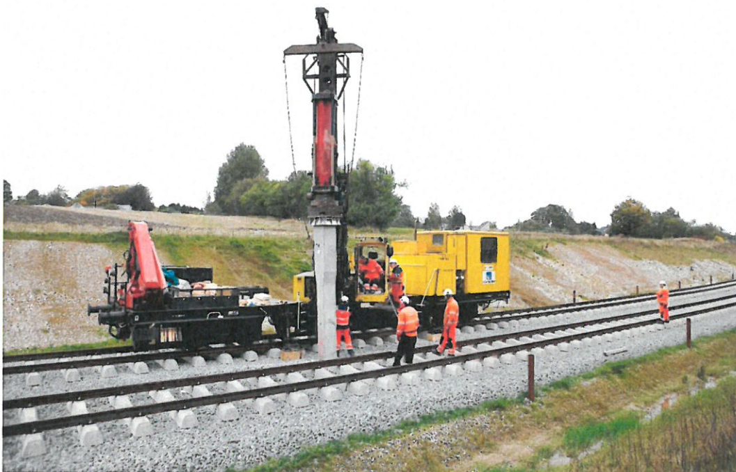
I andet halvår 2016 begyndte arbejdet med at ramme betonfundamenter til kørestrømsmaster på nærbanen til Odder. I alt skal der rammes fundamenter til næsten 3.000 master. Jens Hasse/Chili Foto
