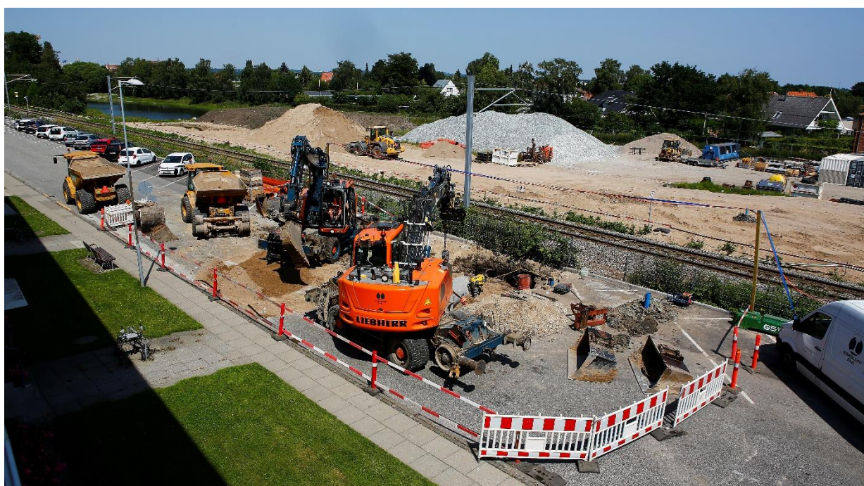
Anlægsarbejde ved og omkring Vestre Strandallé Station i Risskov – Chili Foto.
