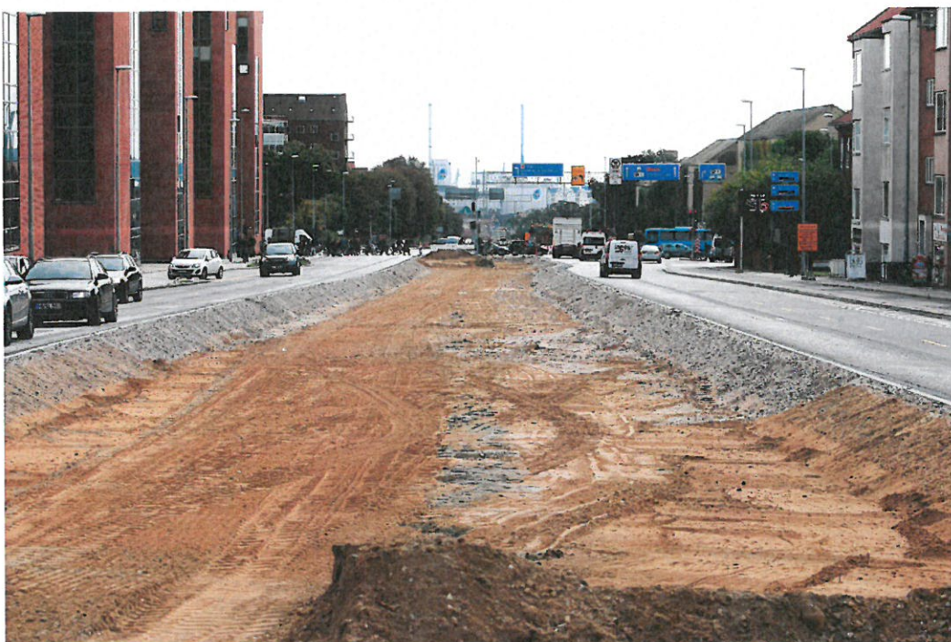
Anlægsarbejdet blev meget synligt i det centrale Aarhus i løbet af 2015 – her udgravningen til letbanens dobbeltspor set fra bunden af Randersvej ned mod Ringgaden og Nørrebrogade. Chili Foto.
